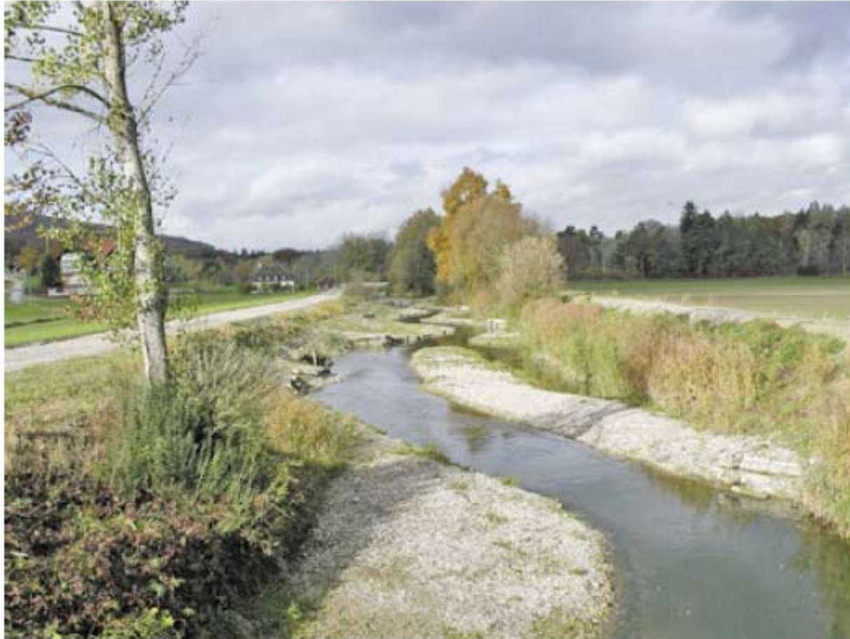
Aufgeweitete und renaturierte Gürbe mit Niederwasserrinne und abgeflachten, variierenden Böschungsneigungen. Blick in Fließrichtung. (Bild M. Zahno)
